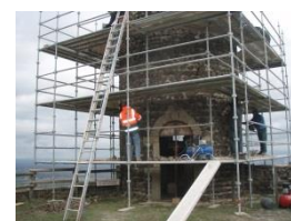
Piquage des murs et soufflage le 23/11 Bourrage au mortier des trous profonds
