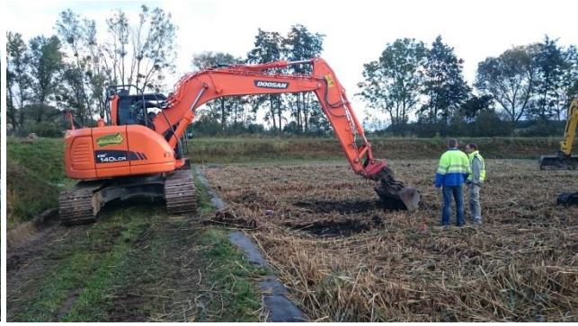
Figure 2 : début du curage par une pelle mécanique
