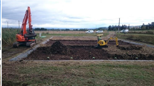
Figure 4 : curage avec la pelle mécanique et la mini pelle
