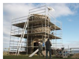
Piquage des murs et soufflage le 23/11 Bourrage au mortier des trous profonds
