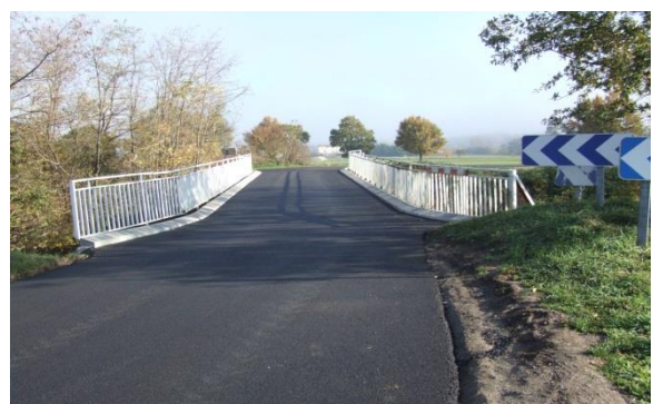
Photo après travaux
