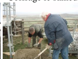
Ferrailage et maçonnerie sur pourtour supérieur les 19 et 20/11 Coulage d'une dalle de béton en couverture le 20/11
