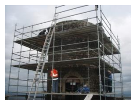
Ferrailage et maçonnerie sur pourtour supérieur les 19 et 20/11 Coulage d'une dalle de béton en couverture le 20/11
