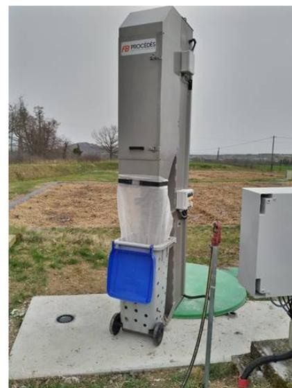
Pose d'un dégrilleur à l'entrée de la station de Corbes
