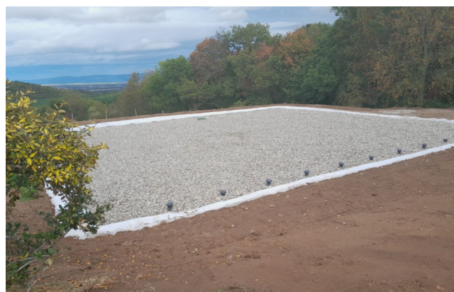
Filtre à sable terminé
