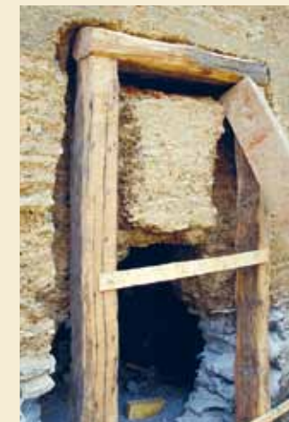
Percement d'une ouverture dans un mur en pisé.
