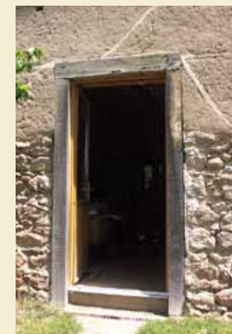
Une nouvelle porte dans une construction en pisé.
