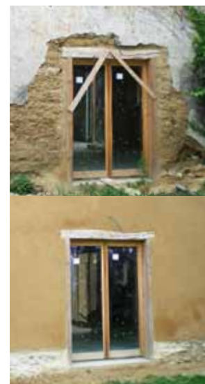
Avant et après reprise de l'enduit
