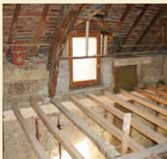
Proposition 2 : Des ouvertures verticales sur toute la hauteur du mur sont possibles, elles seront de préférence réalisées en continuité de l'existant. Des parties de mur en pisé très dégradées (fissure, ravine, effondrement) peuvent être également un endroit privilégié pour réaliser ce type d'intervention
