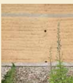
Textures de pisé ancien, rénové et contemporain.
